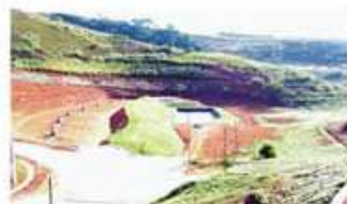
Novo aterro sanitário de Visconde do Rio Branco
